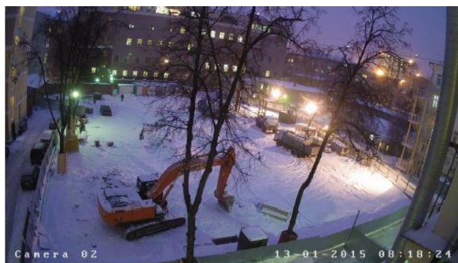
ХОД РАБОТ (ЯНВАРЬ 2015)
