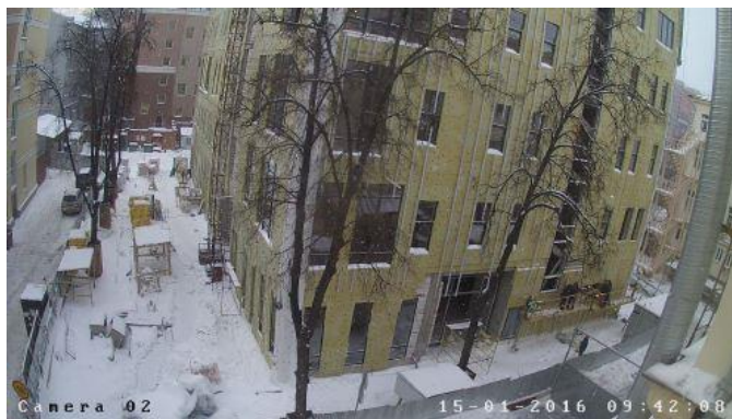
ХОД РАБОТ (ЯНВАРЬ 2016)
